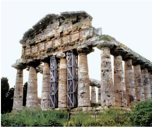
Tempio c.d. di Cerere (Athenaion) durante gli anni '70 dello scorso secolo. Si può notare l'ingrigimento diffuso delle superfici dovuto ad agenti biodeteriogeni e la presenza di opere provvisorie. The so called Ceres temple (Athenaion) during the 70s of the 20 th century. You can notice the greyish colour of the surfaces due to bio-deteriorating agents and the presence of provisional works.
