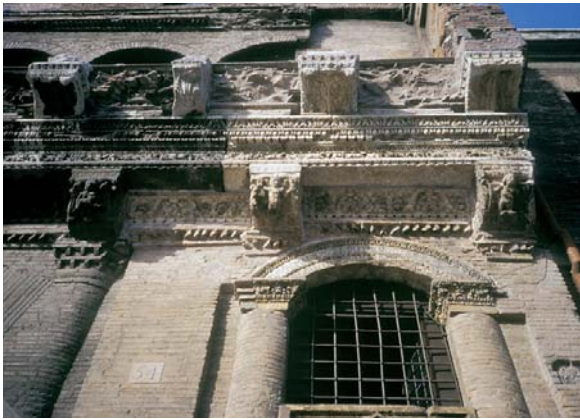
Roma, Via Petroselli. Prospetto della Casa dei Crescenzi durante le fasi di pulitura delle croste nere. Rome, via Petroselli. Prospectus of Casa dei Crescenzi during cleaning treatments of black crusts.
