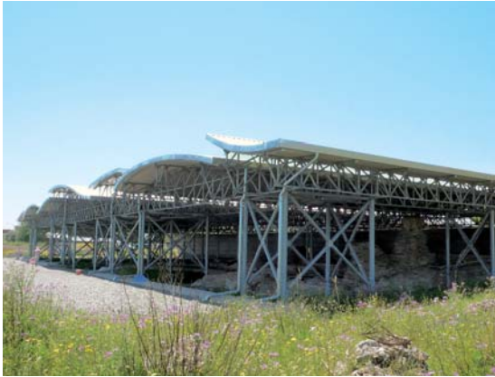
Casignana (RC), copertura sulla Villa Romana; settore est (in corso di completamento). Casignana (Reggio Calabria), shelter over the east area of the Roman Villa; view of the shelter, front side (during the completion work).
