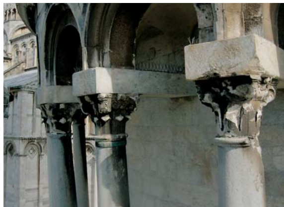
Corrosione, croste nere e disgregazione dei materiali lapidei. Corrosion, black crust and decay of lithoid materials.
