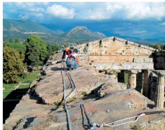
Athenaion durante il restauro. Copertine sommitali realizzate con guaina elastomerica in fase di realizzazione. Athenaion during restoration. Top coverings made up of elastomeric sheet under realisation.
