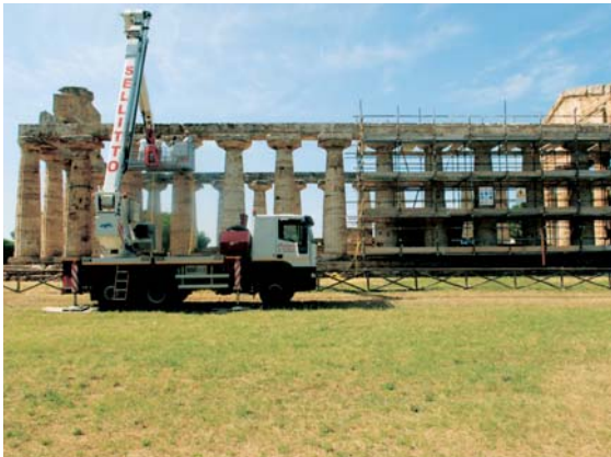
Tempio c.d. Cerere (Athenaion). Realizzazione dell'intervento di manutenzione con ponteggio e braccio mobile: mezzi a confronto. So called Ceres temple (Athenaion). Maintenance intervention using scaffolding and lift truck: means compared.
