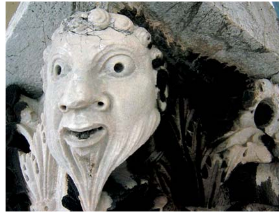
Croste nere e disgregazione dei materiali lapidei 1° ordine. Black crust and decay of lithoid materials 1st level.
