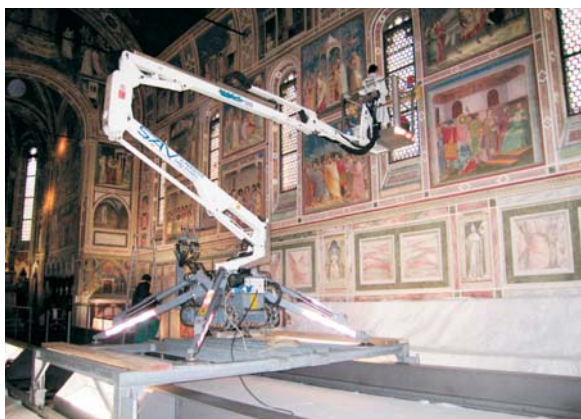
Elevatore meccanico utilizzato nelle operazioni di manutenzione. Mechanical elevator used during the maintenance treatments.
