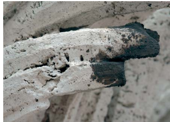
Formazione di croste nere dendritiche su un dettaglio scultoreo di travertino. Dendritic black crusts forming on a sculptured detail in travertine.
