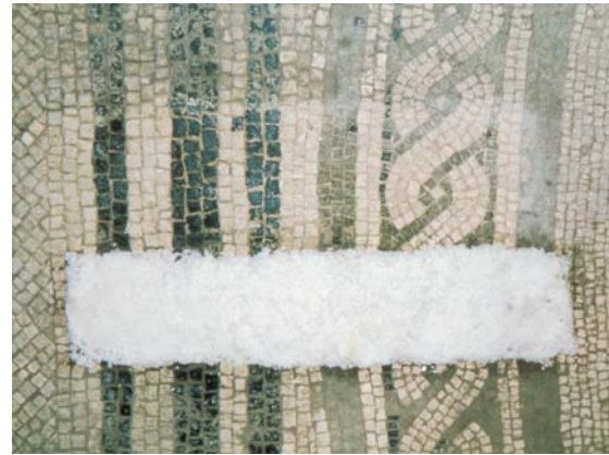
Castelleone di Suasa, Domus dei Coiedii . Mosaico bianco e nero dell'ambiente O, pulitura meccanica con vibroincisore. Castelleone di Suasa, Domus dei Coiedii . White and black mosaic floor of the room O, mechanical cleaning using vibroengraver.
