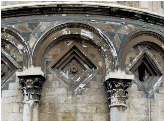
Croste nere e disgregazione dei materiali lapidei 1° ordine. Black crust and decay of lithoid materials 1st level.
