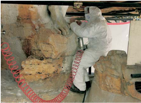
Le complesse operazioni di restauro: la rimozione del calcare con il metodo della micro sabbatura. One of the phase in the elaborate restoration process, the micro-sand blasting cleaning. For the calcareous incrustations removal.
