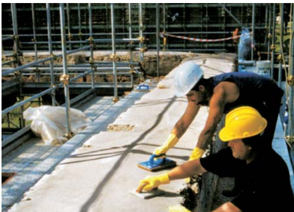
Athenaion durante il restauro. Copertine sommitali realizzate con guaina elastomerica in fase di realizzazione. Athenaion during restoration. Top coverings made up of elastomeric sheet under realisation.
