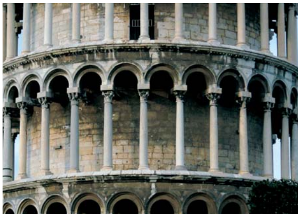
Corrosione, croste nere e disgregazione dei materiali lapidei. Corrosion, black crust and decay of lithoid materials.
