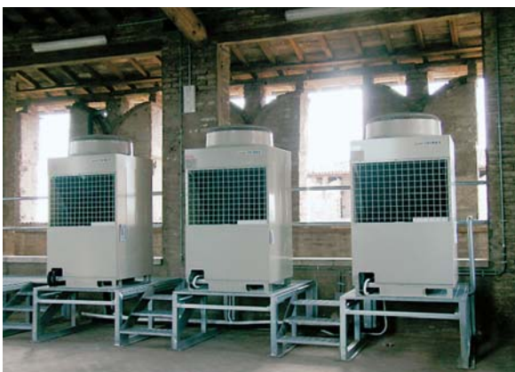
Fig. 5a Mantova. Impianti per il trattamento dell'aria su una terrazza del Palazzo Ducale per il controllo della qualità dell'aria nella Camera Picta. Mantua. HVAC plant installed on a terrace for air quality control in the Camera Picta.
