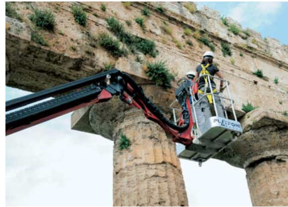
Tempio di Cerere. Trabeazione in travertino colonizzata da licheni endolitici ed epilithici. Ceres temple. Travertine trabeation colonized by endolithic and epilithic lichens.
