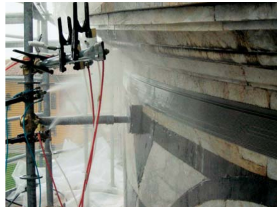
Interventi conservativi sulle geometrie del 1° ordine: intervento di ristabilimento di coesione. Conservative interventions on geometrical decoration, 1st level: treatment to stabilise the decohesed stone.
