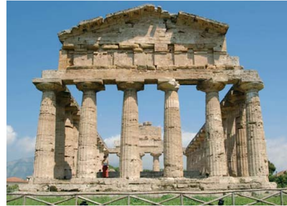
Tempio c.d. di Cerere (Athenaion) durante gli anni '70 dello scorso secolo. Si può notare l'ingrigimento diffuso delle superfici dovuto ad agenti biodeteriogeni e la presenza di opere provvisorie. The so called Ceres temple (Athenaion) during the 70s of the 20 th century. You can notice the greyish colour of the surfaces due to bio-deteriorating agents and the presence of provisional works.
