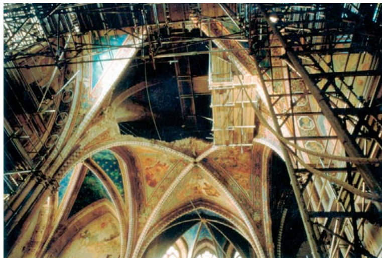
Il crollo di parti della volta della Basilica di San Francesco di Assisi dipinta da Giotto e Cimabue dopo il sisma del 26 settembre 1997.
