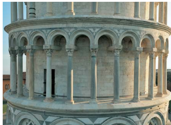
I loggiati del 2° ordine, dopo il restauro. Arches of 2nd level, after restoration.
