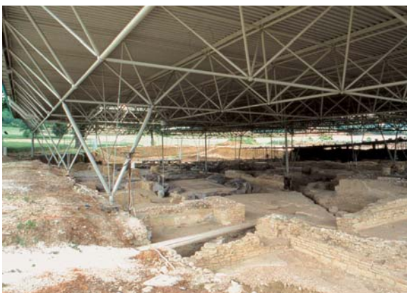
Castelleone di Suasa (AN), copertura sulla Domus dei Coiedii, particolare della struttura di supporto. Castelleone di Suasa (Ancona), shelter over Domus dei Coiedii; detail of the structural elements.
