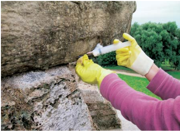
Consolidamento del materiale lapideo. Consolidation of stone material.
