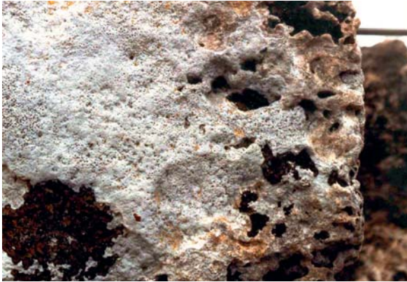
Tempio di Cerere. Trabeazione in travertino colonizzata da licheni endolitici ed epilithici. Ceres temple. Travertine trabeation colonized by endolithic and epilithic lichens.
