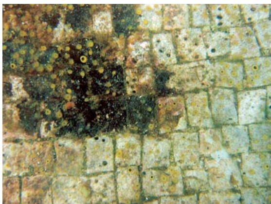
Parco Sommerso di Baia (Napoli). Villa con ingresso a protiro. Pavimentazione musiva con attacco di Cliona sp. viva . Foto NIAS ISCR. Baia Underwater Park (Naples). Villa con ingresso a protiro. Mosaic with Cliona sp. growth . Photo NIAS ISCR.
