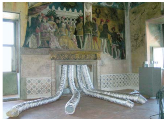
Fig. 5b Mantova. Palazzo Ducale installazione del sistema di trattamento dell'aria nella Camera Picta di Mantegna. Mantua, Palazzo Ducale. Installation of HVAC plant in the Camera Picta by Mantegna.
