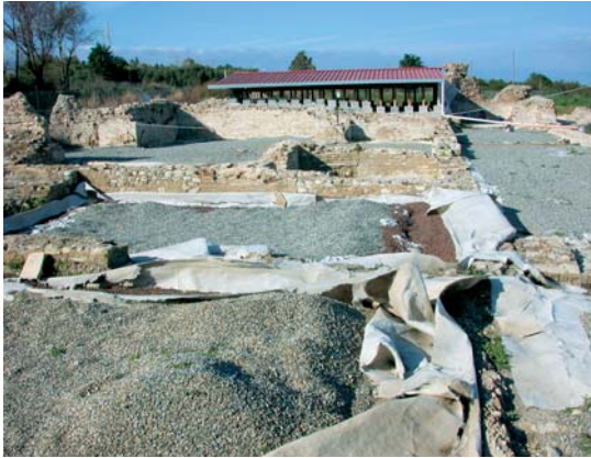
Casignana (RC). Villa Romana, protezione dei mosaici pavimentali nel settore est mediante geosintetici e argilla espansa (prima della costruzione della copertura definitiva). Casignana (Reggio Calabria), Roman Villa, protection of mosaic floors by geotextiles with expanded clay before the construction of the new shelter.
