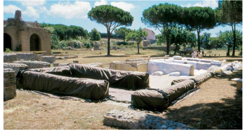
Civitavecchia (Roma). Terme Taurine, cubicula diurna . Sistemi di reinterro temporaneo di mosaici pavimentali e intonaci dipinti con geosintetici o con argilla espansa. Nel dettaglio il pavimento musivo e la parete dipinta protetti con telo di geosintetico (Goretex PTFE). Civitavecchia (Roma). Taurinae Thermae, cubacula diurna . Example of temporary reburial for protection of mosaic floors and wall paintings by geotextiles alone and with expanded clay. Detail, mosaic floor and wall painting covered by geotextiles Goretex PTFE)
